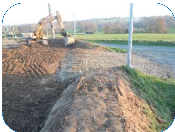
Photos d'aménagement d'une entrée de champ et de création d'un talus (SIAES, 2016)
