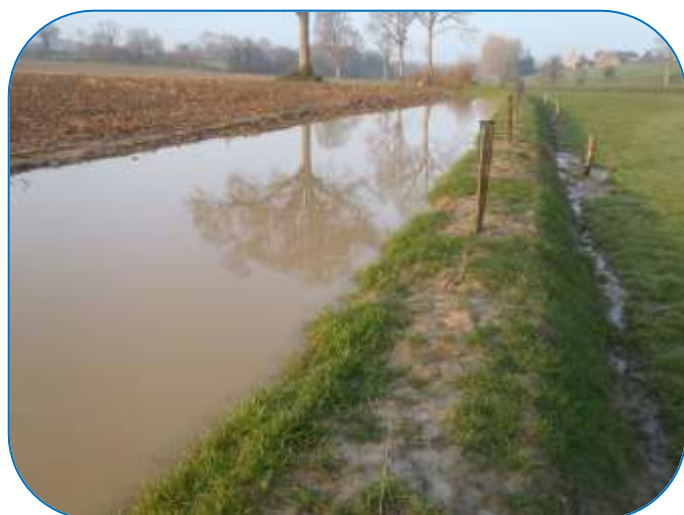
Photos de talus en cours d'aménagement jouant leur rôle hydraulique (SIAES, 2016)
