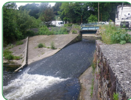
Vue sur le déversoir de la Foulerie
