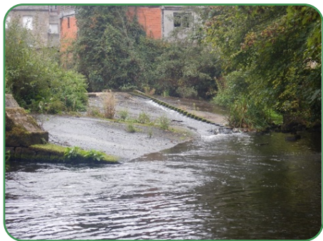
Vue sur le déversoir de Pont Chignon
