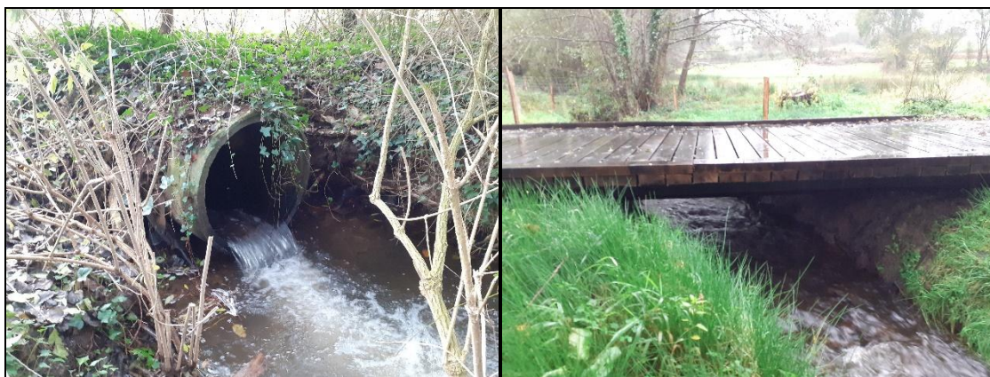
Pour le deuxième ouvrage, une buse agricole a été remplacée par une passerelle à engins.
