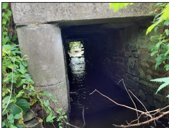
Pont routier de la Charpenterie sur l'Hebarde
