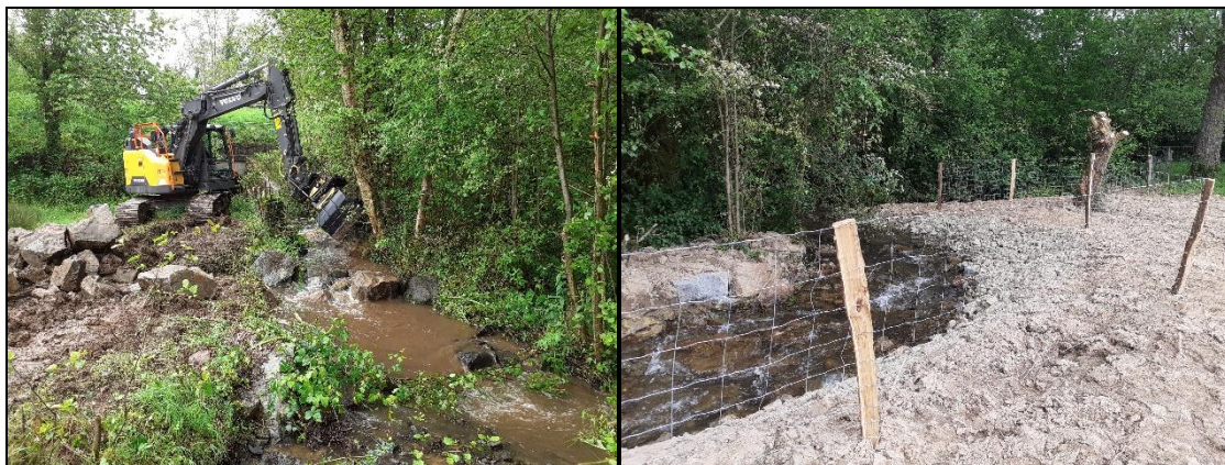
Mise en place du granulat (image de gauche), vue du cours d'eau après travaux (image de droite)
