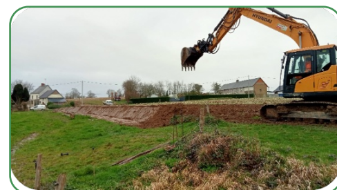
Terrassement d'un talus
