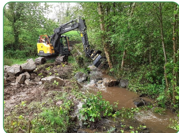
Mise en place du granulat en aval du pont routier
