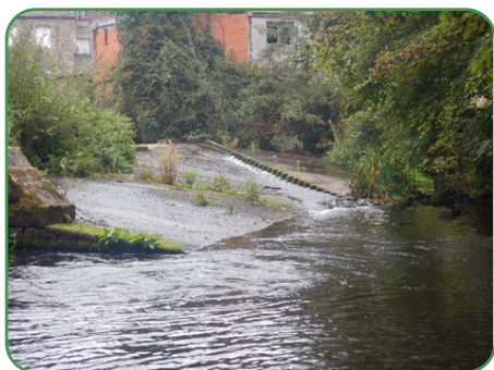
Vue sur le déversoir de Pont Chignon
