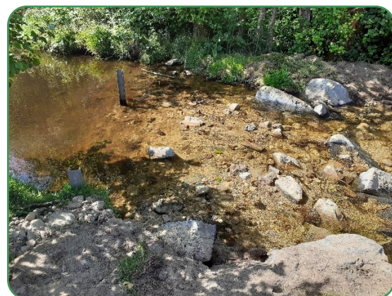
Vue de l'aval du seuil après travaux
